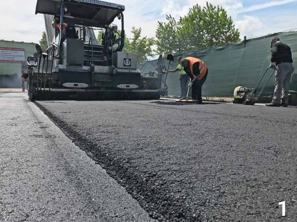
Bild 1: Einbau des Gummiasphaltes
