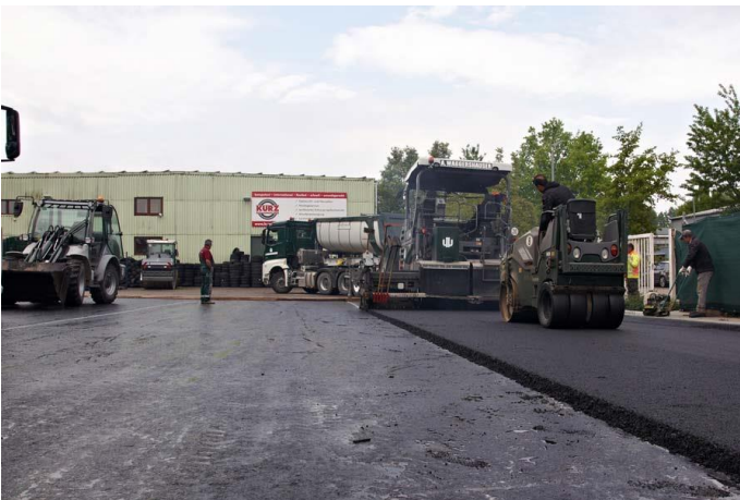
Bild: Der Bau der gummimodifizierten Teststrecke bei Kurz
