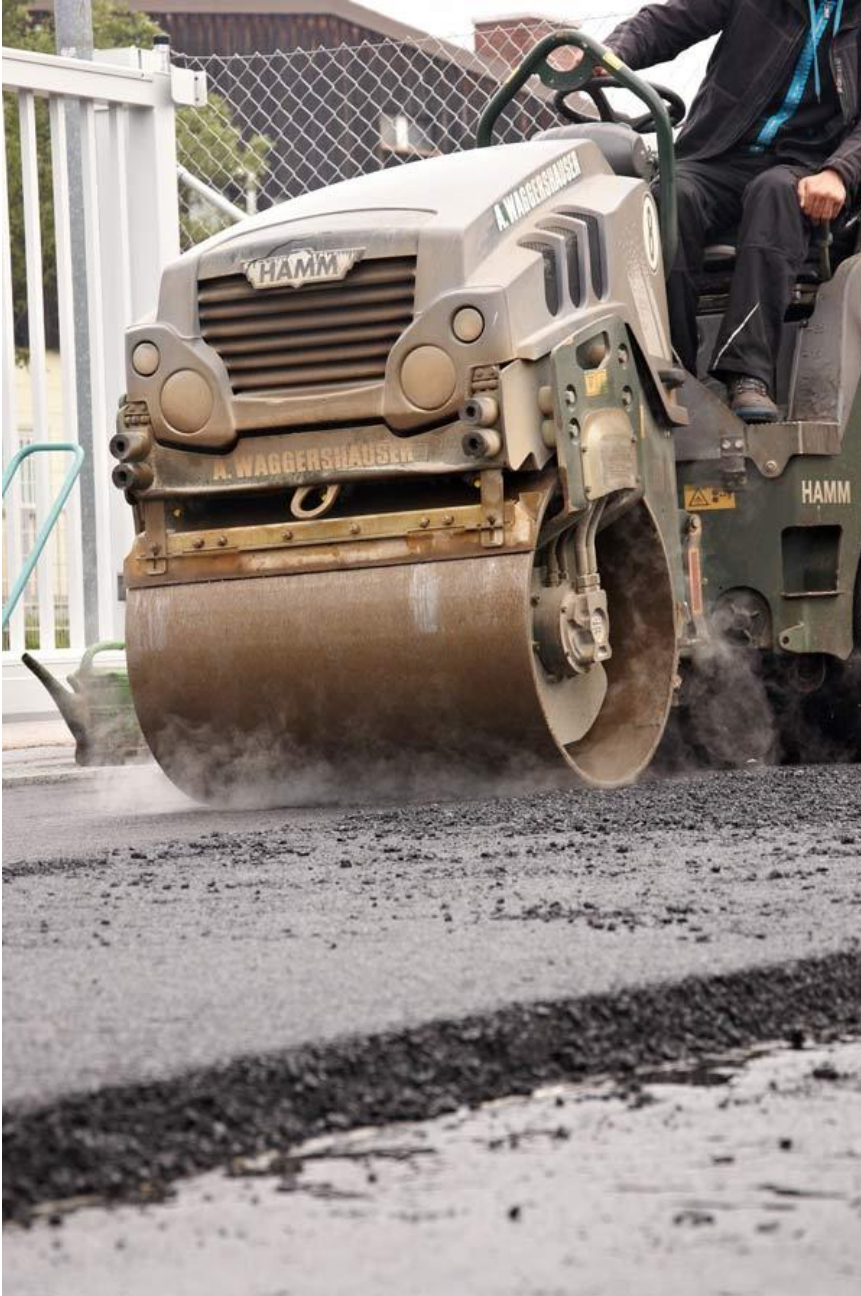
Bild: Der Bau des Gummi-asphalts-Testgeländes bei Kurz
