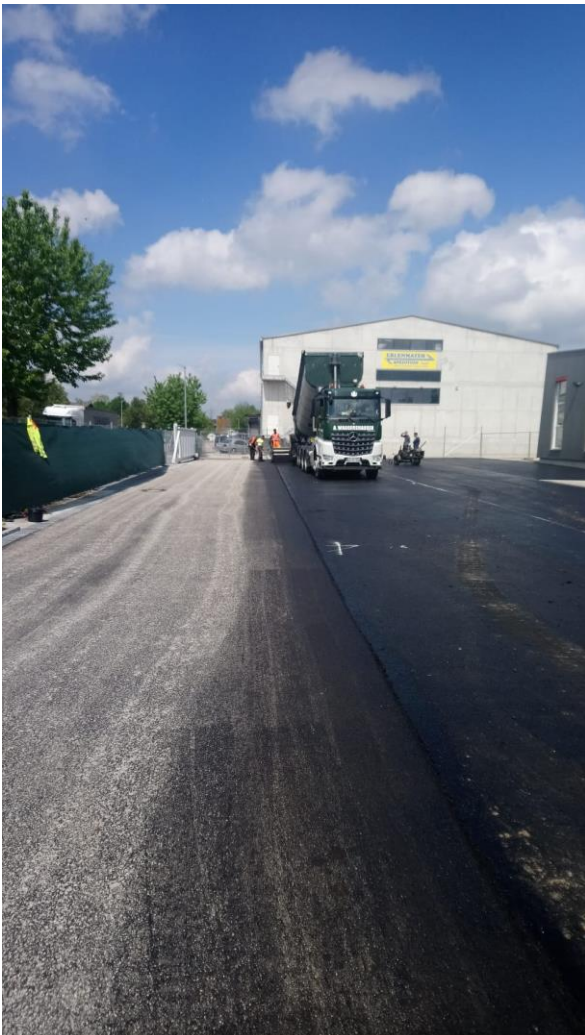
Bild: Die gummimodifizierte Teststrecke bei Kurz
